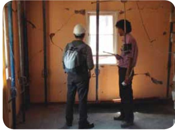
Alzaprima de viviendas con daño estructural.
