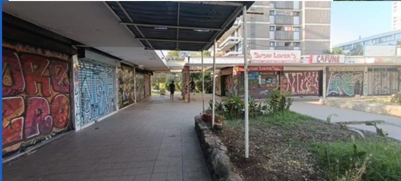
La materialidad de los locales comerciales corresponde a hormigón armado. Pavimentos de baldosas en los exteriores y jardineras con mampostería en piedra
